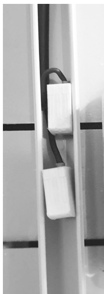
Raccordement dans le conduit de câbles
