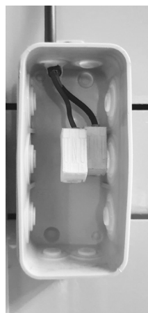
Aansluiting in verdelerdoos
